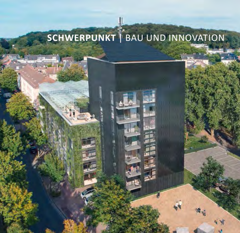
Aus Hochbunker wird Ökohaus: So soll das we-house Herne Ende des Jahres aussehen.
