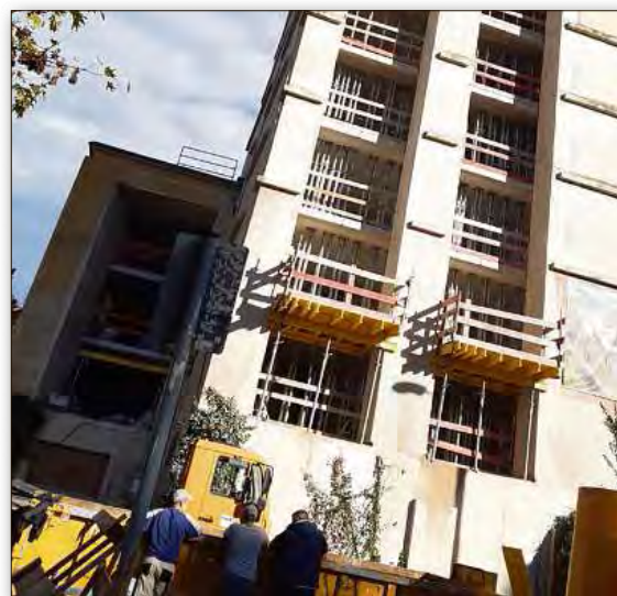
Zurzeit werden Fenster in den Bunker eingesetzt.
